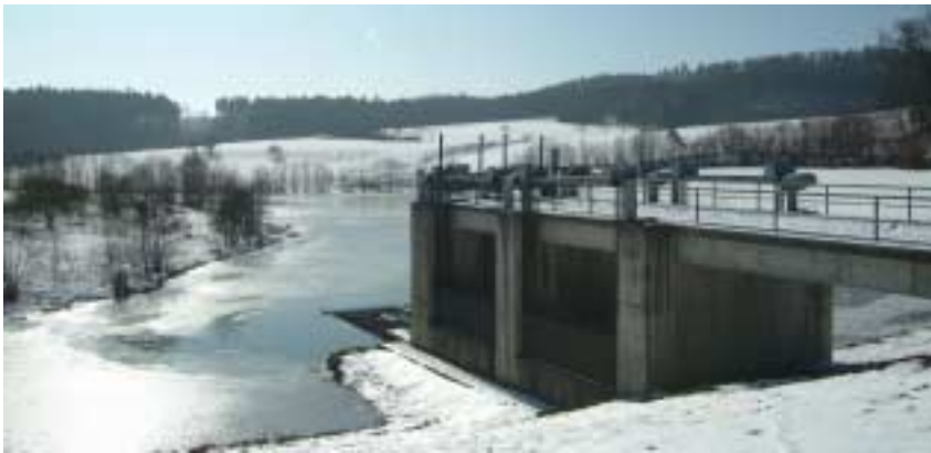
Blick auf den Dauerstau-Bereich des Hochwasserrückhaltebeckens Grimmelshausen im Winter. Bisher war hier für Fische kein Durchkommen.
