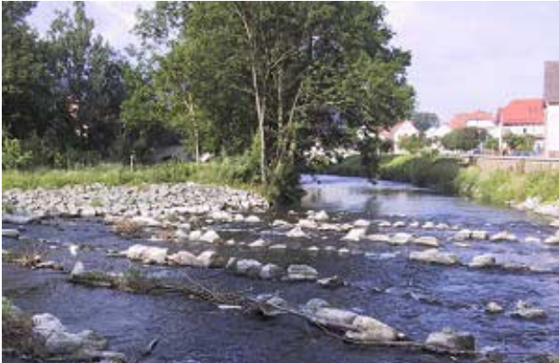
Sohlgleite in Belrieth nach dem Umbau
