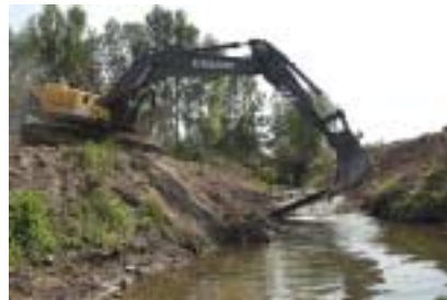
Ein Bagger der Firma Kurz entfernt Betonplatten aus der Elte.
