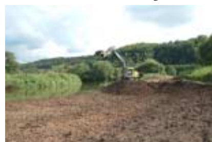
Bauarbeiten zur Uferabflachung im Sallmannshäuser Bogen
